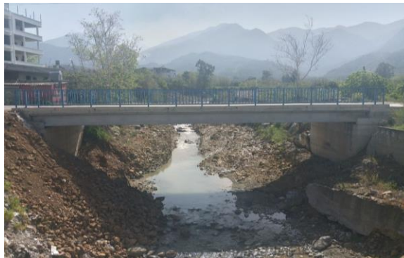
Resim 9. Arsuz ilçesinde yıkım sonrası yenilenen Höyük Köprüsü
