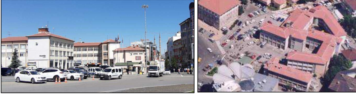
Şekil 31. Belediye Hizmet Binası ve Belediye Çarşısı (Yağcı Topcu arşivi, 2021) ve (Sivas Belediyesi, 2014).
